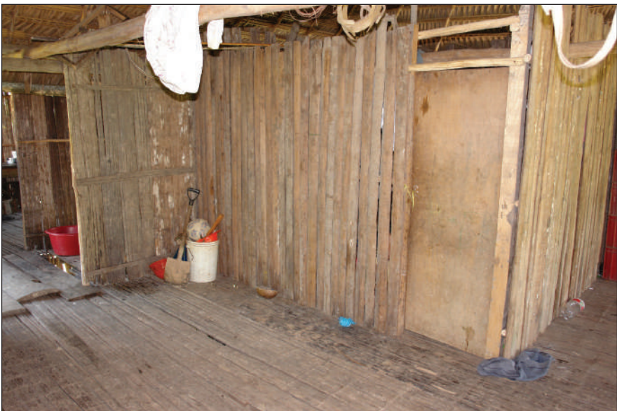
Figura 6 – Paredes elaboradas a partir de troncos de Euterpe precatória “Huasaí” y piso de Iriartea deltoidea “Huacrapona”
